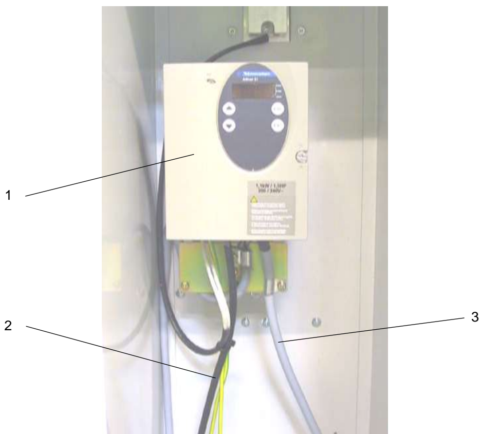
Manipulatorul ZA04 - convertorul de frecvență
